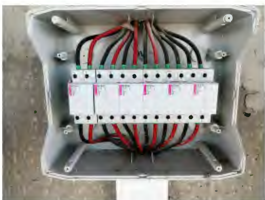
Рисунок 5.4. Фото- та тепловізійна фіксація щита захисту інвертора 4.
