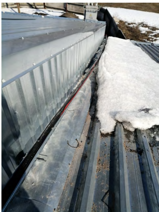
Рисунок 6.1. Неякісне виконання кабельних каналів постійного струму.
