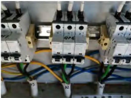
Рисунок 7.5. Фото- та тепловізійна фіксація розподільчого АВ (QF6).
