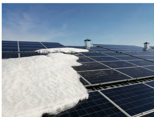
Рисунок 8.1. Фіксація снігу та бруду на фотоелектричних модулях.
