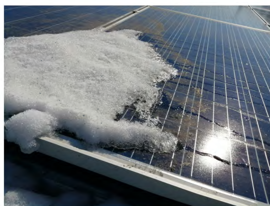
Рисунок 8.1. Фіксація снігу та бруду на фотоелектричних модулях.
