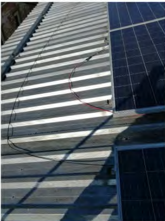
Рисунок 6.3. Відсутність фіксації кабелів та конекторів.
