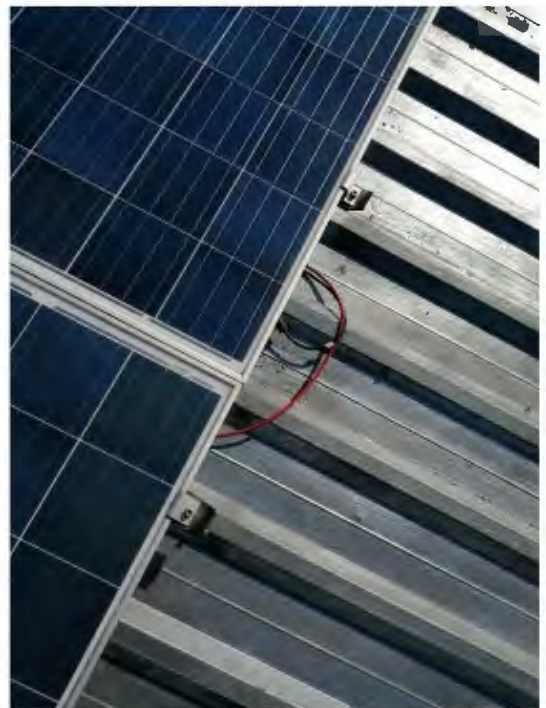
Рисунок 6.3. Відсутність фіксації кабелів та конекторів.
