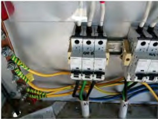
Рисунок 7.3. Фото- та тепловізійна фіксація розподільчого АВ (QF8).
