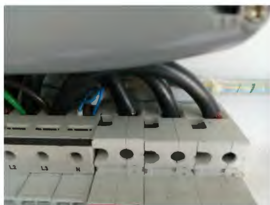
Рисунок 7.8. Неналежне окінцювання кабелів та доступність струмоведучих частин для дотику.
