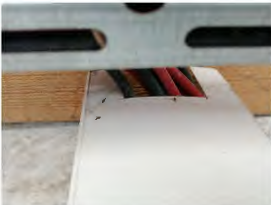
Рисунок 6.2. Ризик пошкодження ізоляції кабелів.
