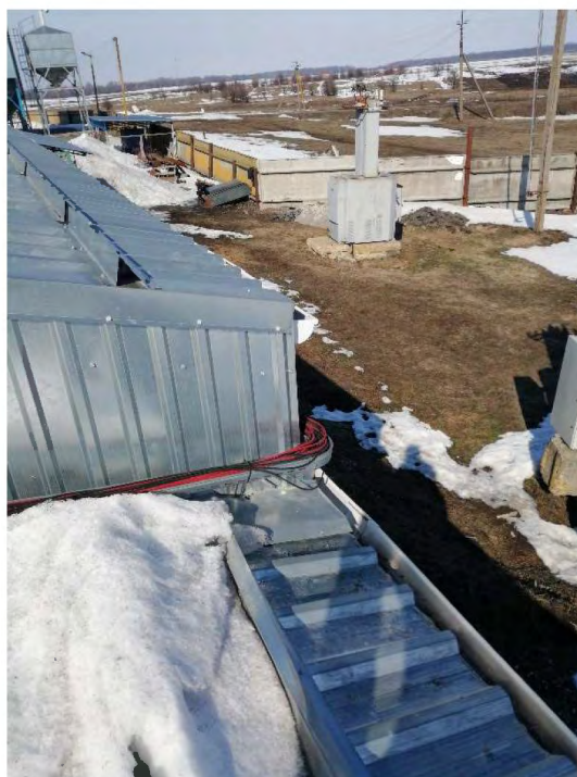
Рисунок 6.1. Неякісне виконання кабельних каналів постійного струму.
