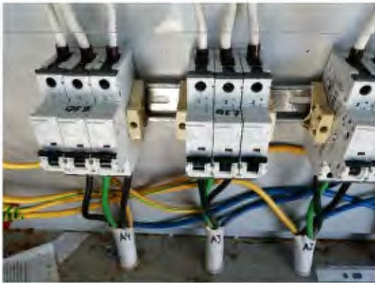
Рисунок 7.4. Фото- та тепловізійна фіксація розподільчого АВ (QF7).
