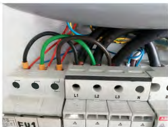
Рисунок 7.8. Неналежне окінцювання кабелів та доступність струмоведучих частин для дотику.
