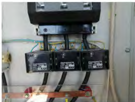
Рисунок 7.2. Фото- та тепловізійна фіксація трансформаторів струму.
