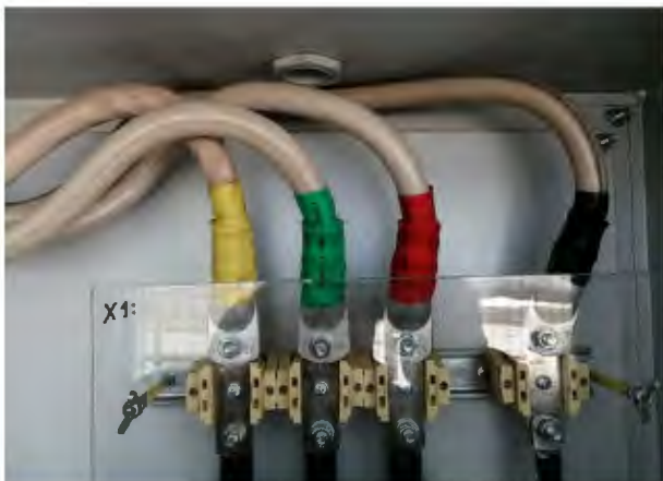
Рисунок 7.7. Фото- та тепловізійна фіксація під'єднання кабелю від РП-0.4 кВ КТП.
