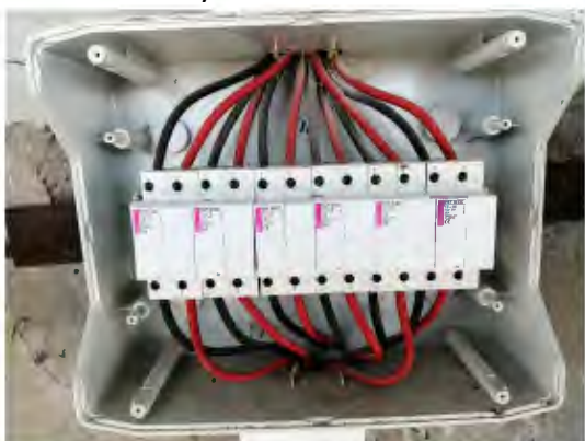
Рисунок 5.2. Фото- та тепловізійна фіксація щита захисту інвертора 2.
